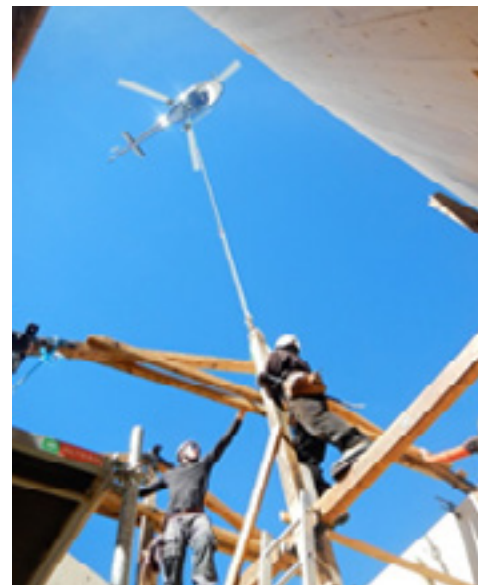
Illustration 24 : Pose de l'ancienne charpente au sein du nouveau refuge de l'Aigle, URL : http://www.refugedelaigle.fr/l-actualit%C3%A9-du-rocher/
