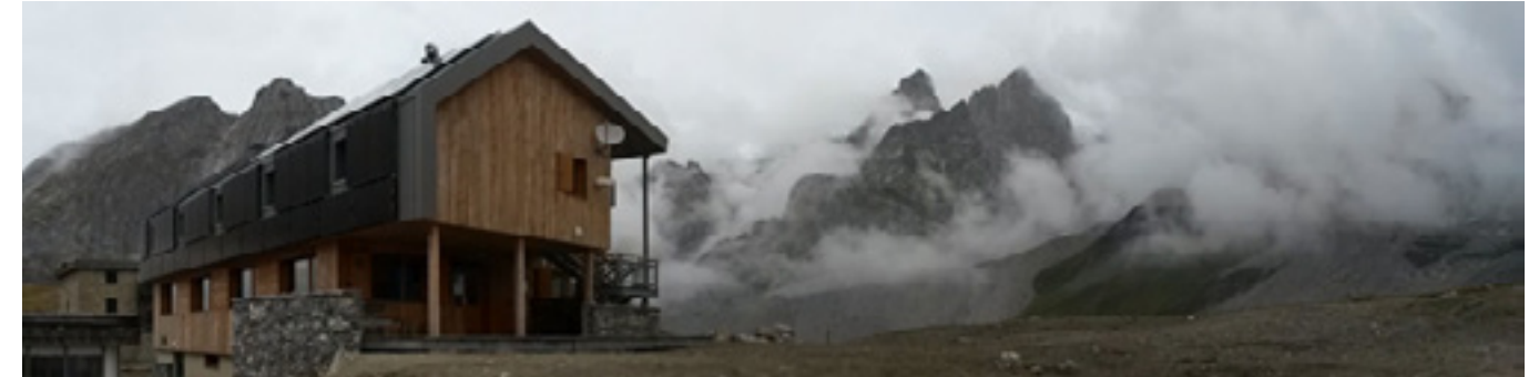
Illustration 8 : Le nouveau refuge du Col de la Vanoise, réhabilité en 2013, BELMONT M., 2014.
